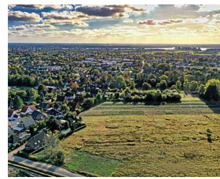
In einem ersten Bauabschnitt sollen 560 Wohnungen entstehen. LANDWERK
